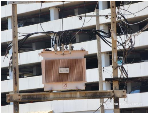
รูปที่ 26 หม้อแปลงไฟฟ้าและเครื่องตัดไฟอัตโนมัติ
