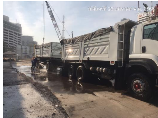
รูปที่ 4 คลุมรถบรรทุกที่ใช้ขนส่งดิน
