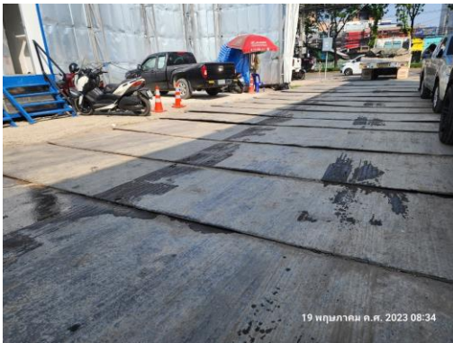
รูปที่ 11 แผ่นปูเหล็ก (Platform)
